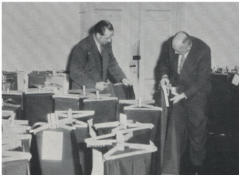
Nicht alle Samte werden auf Rollen aufgemacht, vielmehr müssen die empfindlicheren Qualitäten aufgerahmt werden, damit sie beim Transport nicht beschädigt werden.
